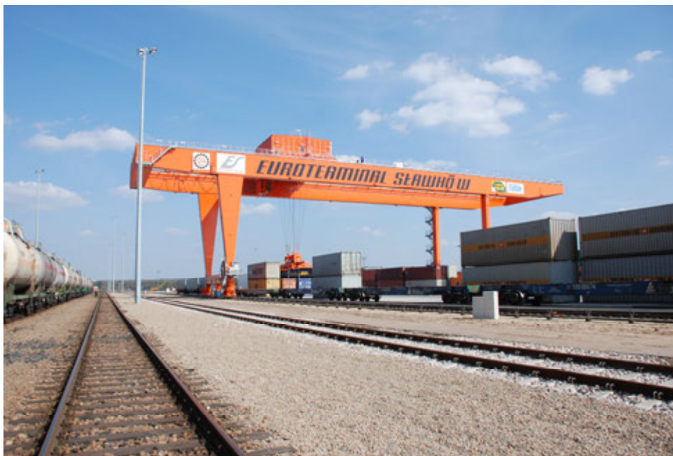
Rys. 4. Suwnica kontenerowa firmy F.M. i U. FAMAK S.A podczas pracy
