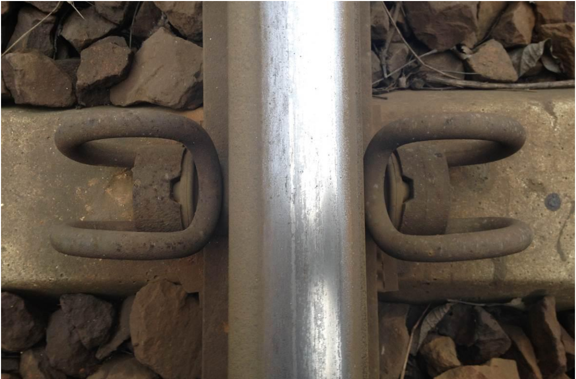
Rys. 2 - Mocowanie sprężyste typu SB-3
